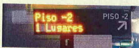
Painel de Lotação de Próximo Piso
